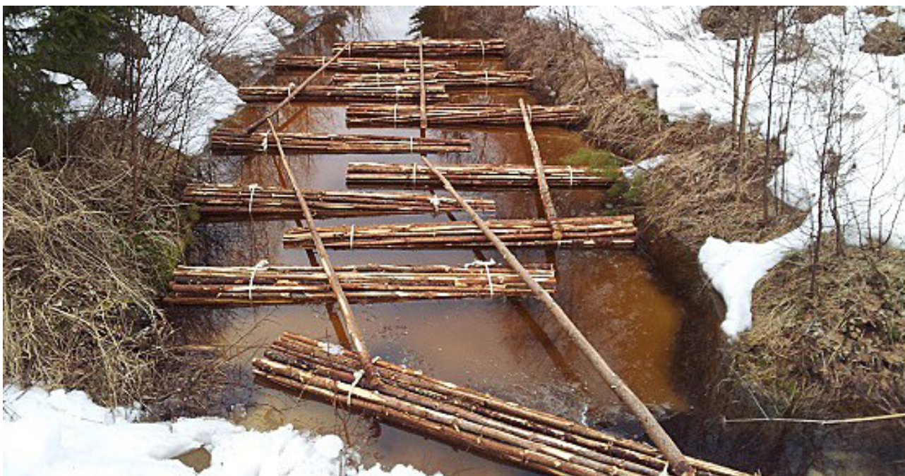
Kuva 6. Sidottuja rankanippuja poikittain uomassa. Kuvaja Esko Keskinen, Syke.
